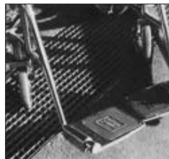
A1-6 Griglia conforme alla normativa (verificare la dimensione della maglia che deve essere inattraversabile da una sfera di 15 mm)
