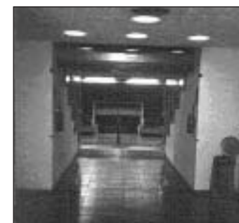
A1-11 Porta a vetri non segnalata e priva di elemento di segnalazione della trasparenza
