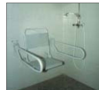
A1-16 Doccia disabile, a filo pavimento, dotata di seggiolino
