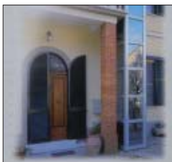
A1-8 Esempio di superamento tramite piattaforma elevatrice
