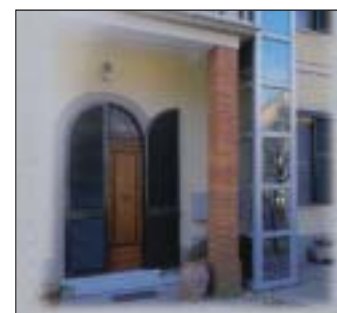
A1-17 Esempio di piattaforma elevatrice
