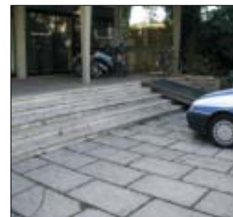
B1-7 Necessità di inserire rampa di adeguate dimensioni per superamento serie di gradini
